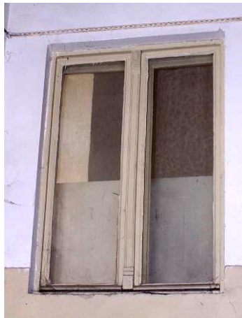
Škola Žilina. Mosadzné olivy zachované na jedinom interiérovom, pôvodnom okne (bývalá vrátnica pri vstupnom schodisku). Okenná výplň hodnotný prvok 308. Podrobnejšie vid'. výkresy Ing.arch. Grúňová, 2015.
