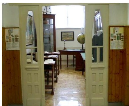
Škola v Győri, analogická geometria členenia dverných výplní, totožné plné dverné krídla vrátane zárubní so zuborezovým motívom. V presklených stenách s dvojkrídlými dverami sú totožné mosadzné tyče.
