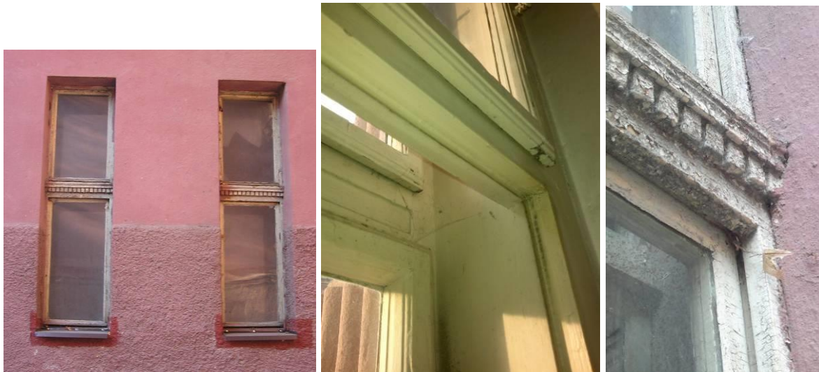
Exteriér školy v Žiline (hore) zachovali sa štyri okná s priečnikom so zuborezom (telocvičňa a severná dvorová fasáda). Hore foto okna – hodnotný detail 309.
