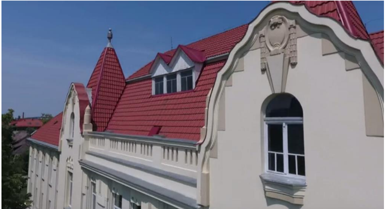
Reštaurované štukové prvky fasád. Štuková kartuša, reštaurovanie gymnasia Užhorod. Totožná kartuša je v torzálnom stave osadená na severnej fasáde v štíte školy v Žiline. Zdroj: http://zakarpattya.net.ua/Zmi/114761-V-Uzhhorodi-zavershyly-restavratsiiu-fasadu-Linhvistychnoi-himnazii-VIDEO a https://www.youtube.com/watch?v=iSAGIXwf8M4
