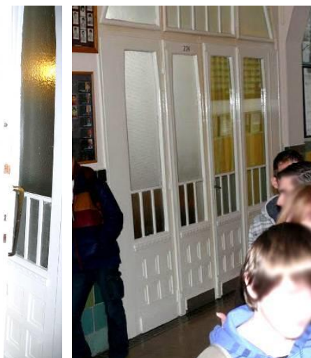
Vľavo a v strede škola v Szegedi, presklená stena s dverami škola Žilina, vpravo. Opäť takmer rovnaké delenie, totožná geometrická výzdoba aj kovania vrátane mosadzných tyčí.
