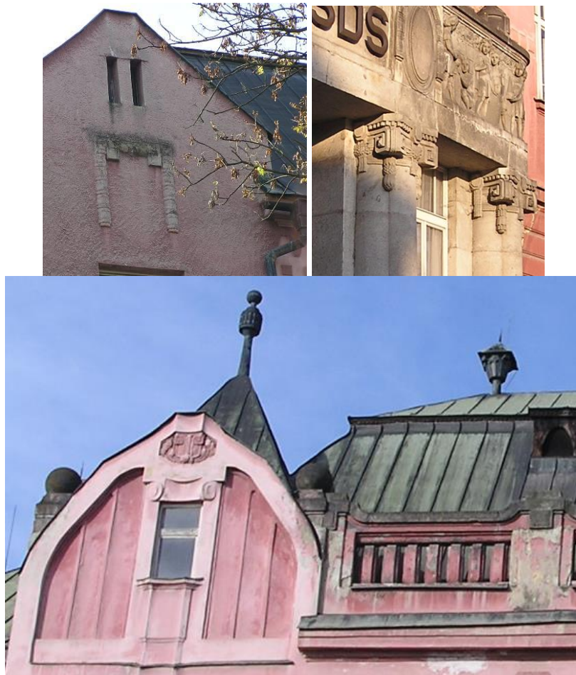
Škola Žilina. Čiastočne zachovaný motív kartuše v štíte severnej fasády. Kamenné hlavice portálu na východnej fasáde. Detail východnej fasády s balustrami atiky.
