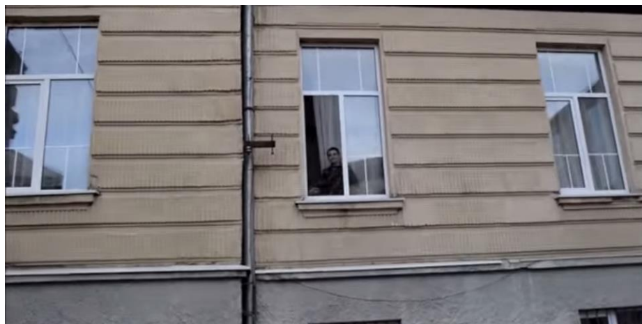
Reštaurované štukové prvky fasád, 2012. Gymnázium Užhorod. Rustika s profiláciou je rovnaká ako v Žiline, aj profilácia sokla. Okná vymenené za nové, plastové, už len s náznakom pôvodného členenia.
