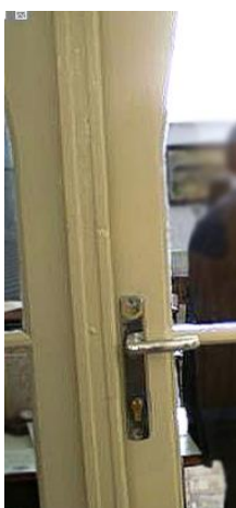
Škola v Győri, analogická geometria členenia dverných výplní, totožné plné dverné krídla vrátane zárubní so zuborezovým motívom. V presklených stenách s dvojkrídlými dverami sú totožné mosadzné tyče.
