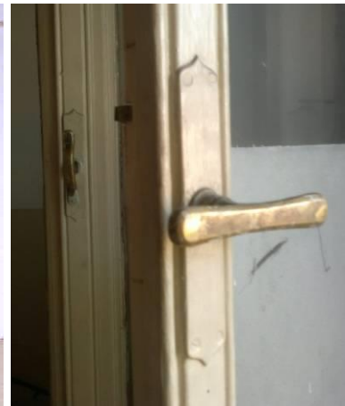
Škola Žilina. Mosadzné olivy zachované na jedinom interiérovom, pôvodnom okne (bývalá vrátnica pri vstupnom schodisku). Okenná výplň hodnotný prvok 308. Podrobnejšie vid'. výkresy Ing.arch. Grúňová, 2015.
